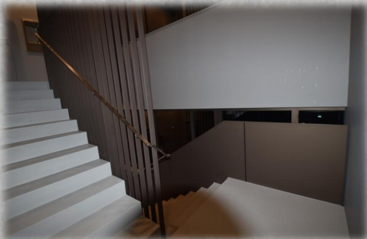
Barrière de cage d'escalier Chocolats Camille Bloch SA 2608 Courtelary Architectes: Bauart Architectes et Urbanistes SA
