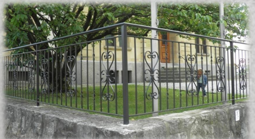
Garde-corps entrée principale Administration communale 2034 Peseux
