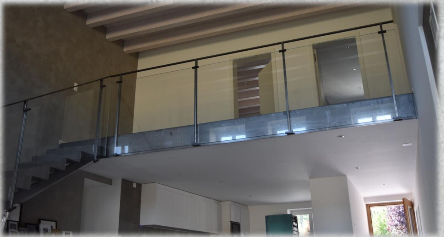
Escalier intérieur en acier brut (cire d'abeille) et verre Villa individuelle 1588 Cudrefin
