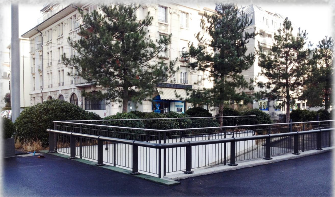
Barrière et glissière de sécurité Royal Savoy Lausanne Hôtel 1006 Lausanne Architectes: Itten+Brechbühl SA
