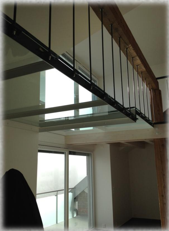
Plancher en verre feuilleté transparent suspendu à la poutraison existante Villa individuelle 2068 Hauterive
