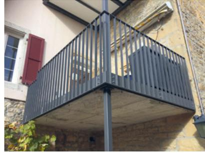
Balcon en structure acier avec
